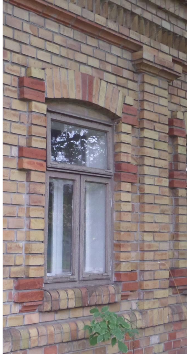
Szép idomtégglák, ablakkeretek és áloszlop.
